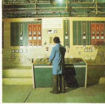
Kimyasal Terbiye Ünitesi Elektronik Kontrol Panosu
